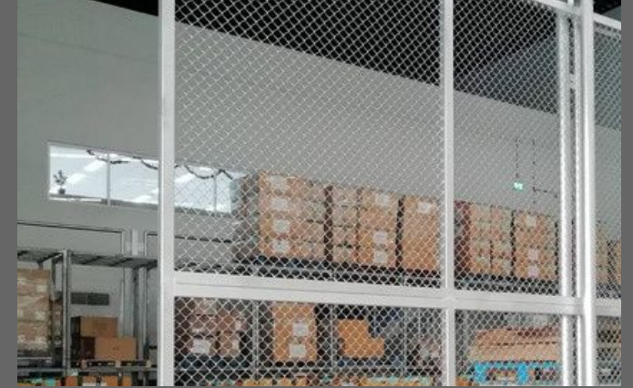
งานติดตั้งแผงประตูห้องสตอร์
