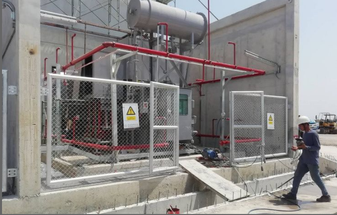
งานติดตั้งแผงกันหม้อแปลง
