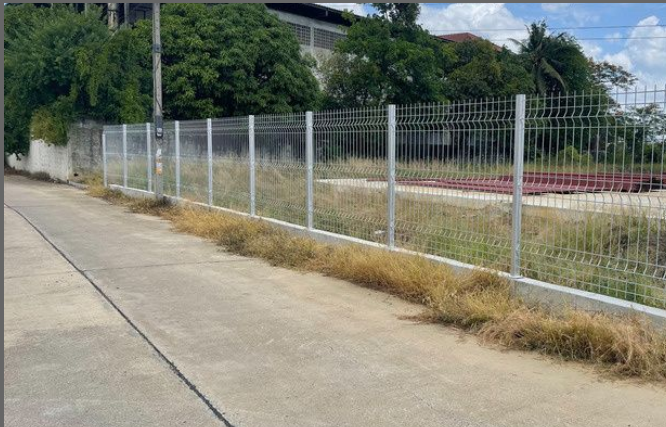
งานติดตั้งแผงรั้วล้อมพื้นที่
