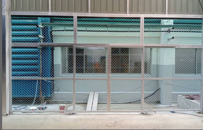
งานติดตั้งแผงและประตู
