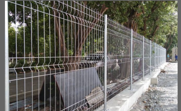
งานติดตั้งแผงรั้วล้อมบ้าน
